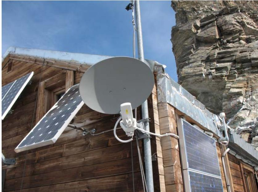
*Sistema di comunicazione installato presso la capanna Carrel*
